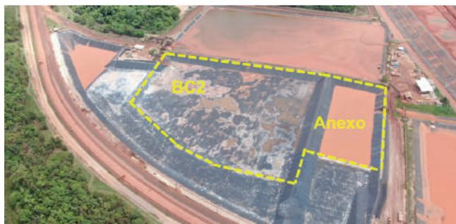
Ampliação da bacia BC-02 em 135 mil m<sup>3</sup>, aumentando sua capacidade em 56%. A necessidade foi observada através do monitoramento meteorológico realizado constantemente pela empresa. A ação garante a segurança hídrica da planta, em vista às mudanças climáticas.
